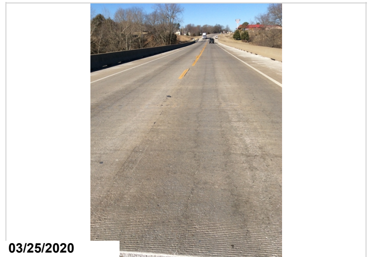
Longitudinal cracking
